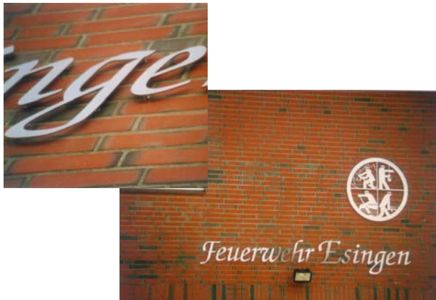
Abb. 1: Schriftzug und Logo aus 5 mm starkem Edelstahl dekupiert, Oberfläche fein geschliffen.
