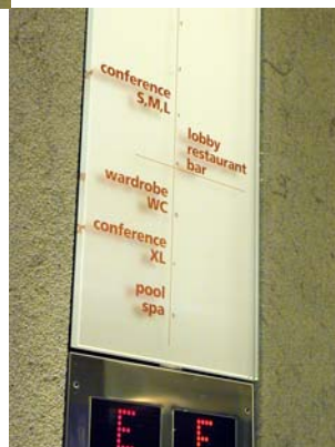
Abb. 4: Liftschild aus 10 mm Glas , Oberfläche fein geätzt, Rückseite verspiegelt, Kanten poliert; Beschriftung im Siebdruck nach Pantone, Montage bündig in die Wandverkleidung
